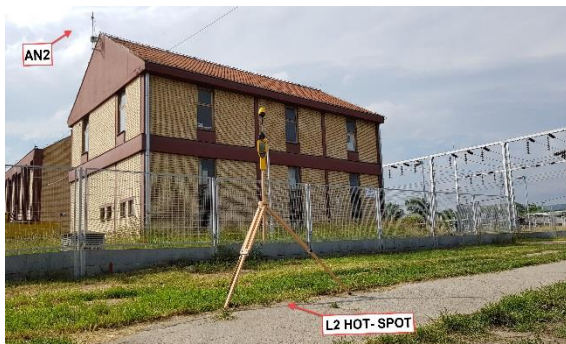
SLIKA 2. TRANSFORMATORSKA STANICA "NOVI SAD 7" LOKACIJA L2
